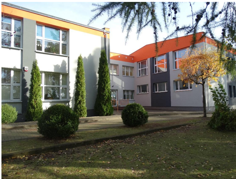
Fot. 5. Termomodernizacja budynku Szkoły Podstawowej w Zegrzu
