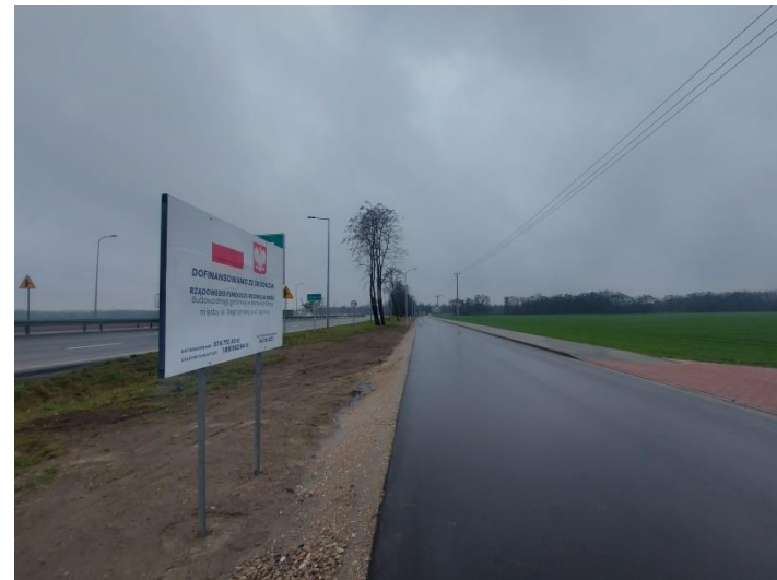
Fot. 4 Budowa drogi w Borowej Górze
