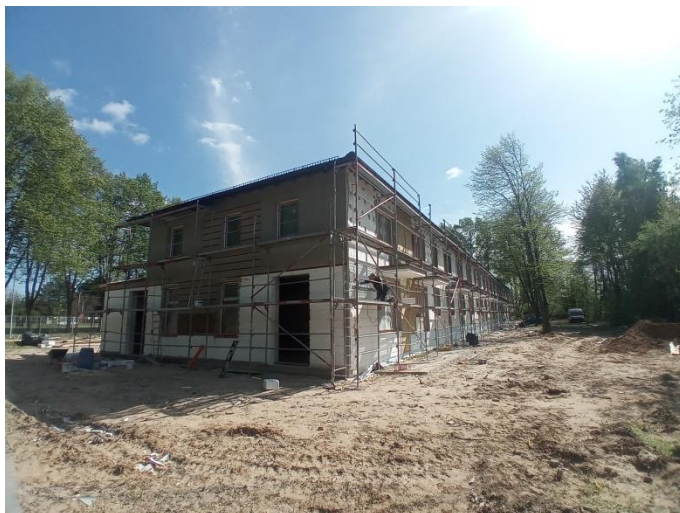
Fot. 5 Budowa budynku komunalnego w Borowej Górze
