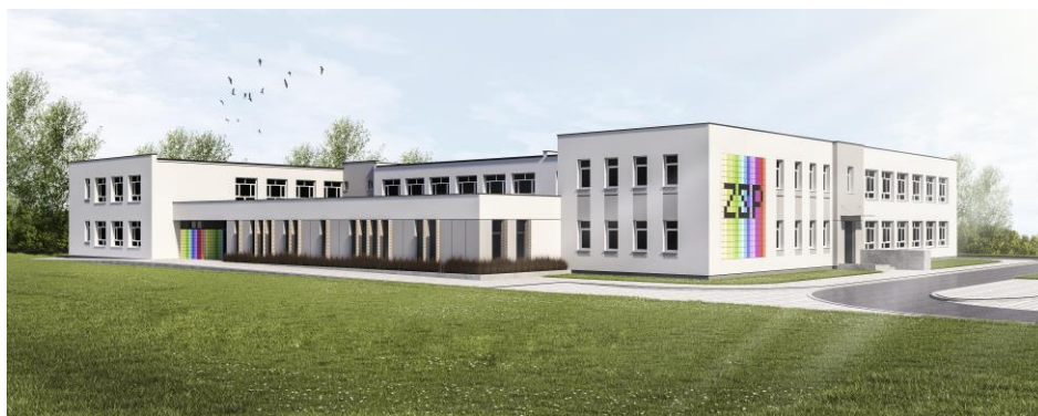
Zespół Szkolno – Przedszkolny w Woli Kiełpińskiej po rozbudowie
