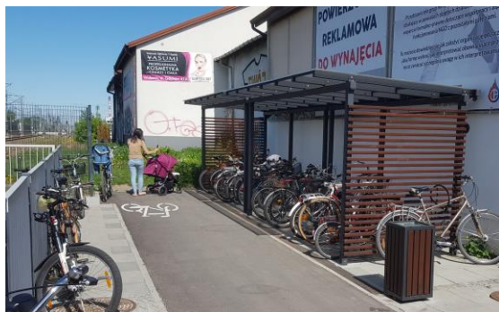
Rys. 7.2 Zadaszony parking B+R w Wołominie
